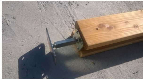
Fixations pied de poteau fixe avec 4 vis 8/80 tête disque
